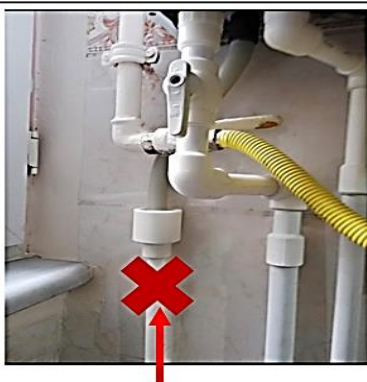
Sıkı geçme değil hatalı uygulama
